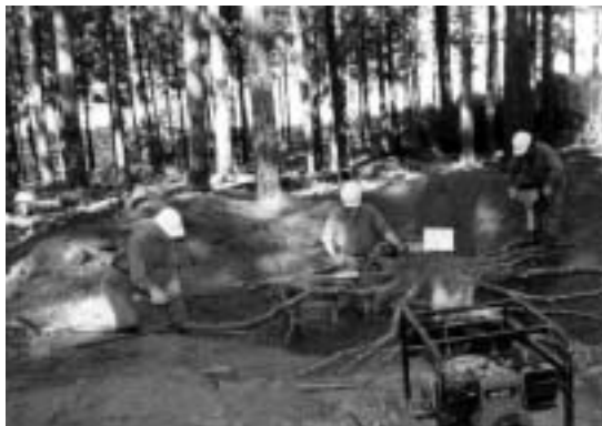
Figura 1. Izquierda: Exposición de las raíces, mediante excavación manual y mecánica. Derecha: trípode y tecla de cadena de 3 t.
